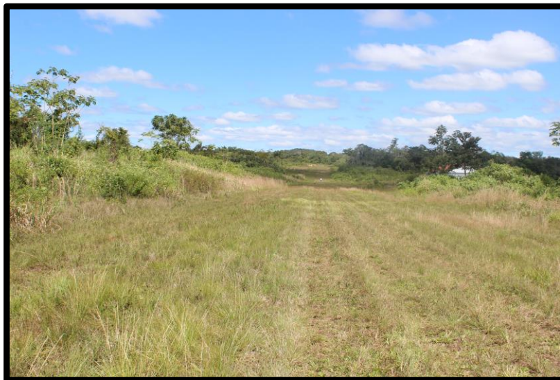
Fotografía No.20 Vista de la inclinación de la pista en dirección de vuelo en ascenso.
